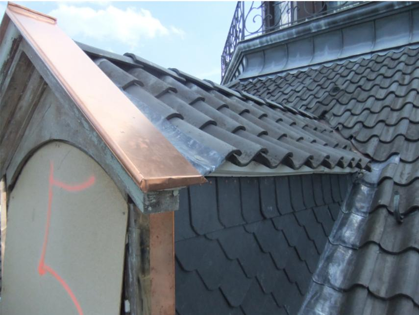
Die Dacheindeckungs- und Klempnerarbeiten an den oberen Gauben sind abgeschlossen. Die Gaubenwangen sind wieder mit Naturschiefer verkleidet.
