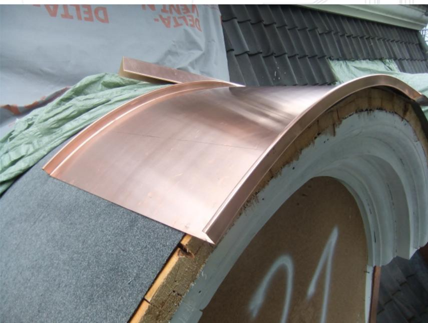
Die Klempner arbeiten an der Kupferblecheindeckung der Tonnendächer der unteren Gauben. Die Eindeckung erfolgt in Stehfalzdeckung.
