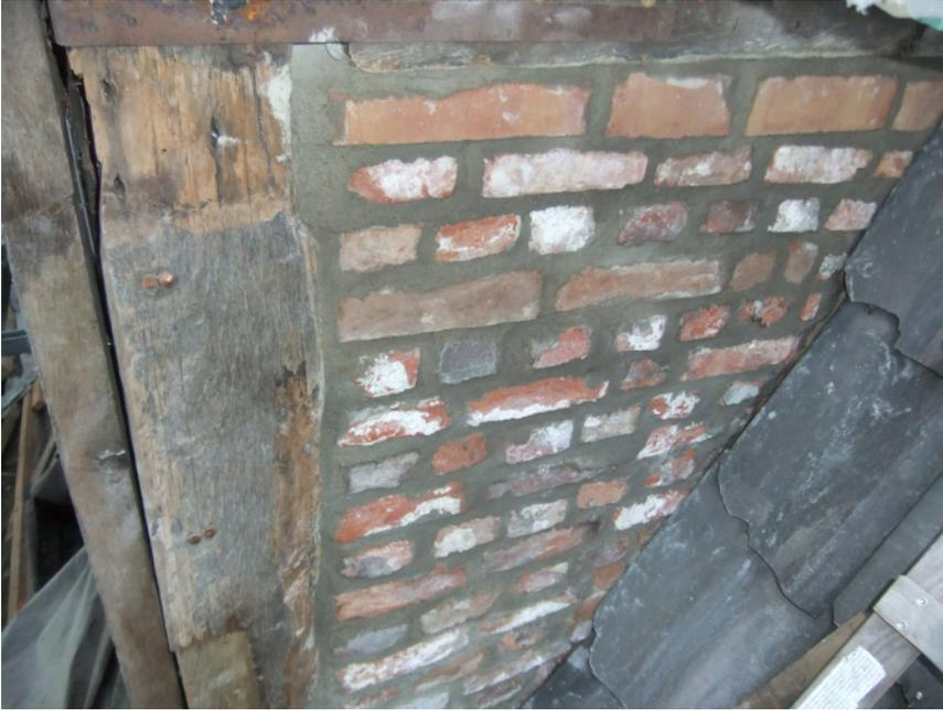
Einige Gefache der Gaubenwangen wurden neu aufgemauert. Als Mauer- und Fugenmörtel wurde ein reiner Kalkmörtel verwendet.
