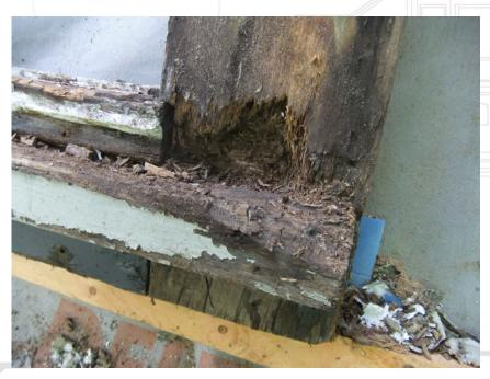
Geschädigtes Unterstück eines Blendrahmens der großen unteren Gaubenebene. Der Blendrahmen wurde ausgebaut und das Unterstück wird in Eichenholz neu hergestellt.
