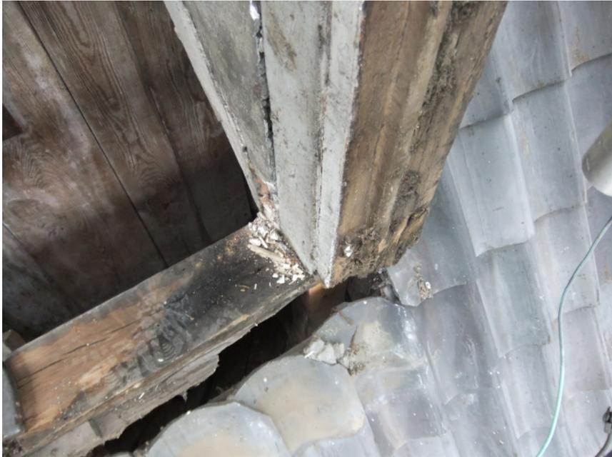
Die Gaubenkonstruktion wurde freigelegt und die Schäden aufgenommen. An fast allen Gauben musste die Tragkonstruktion saniert werden.
