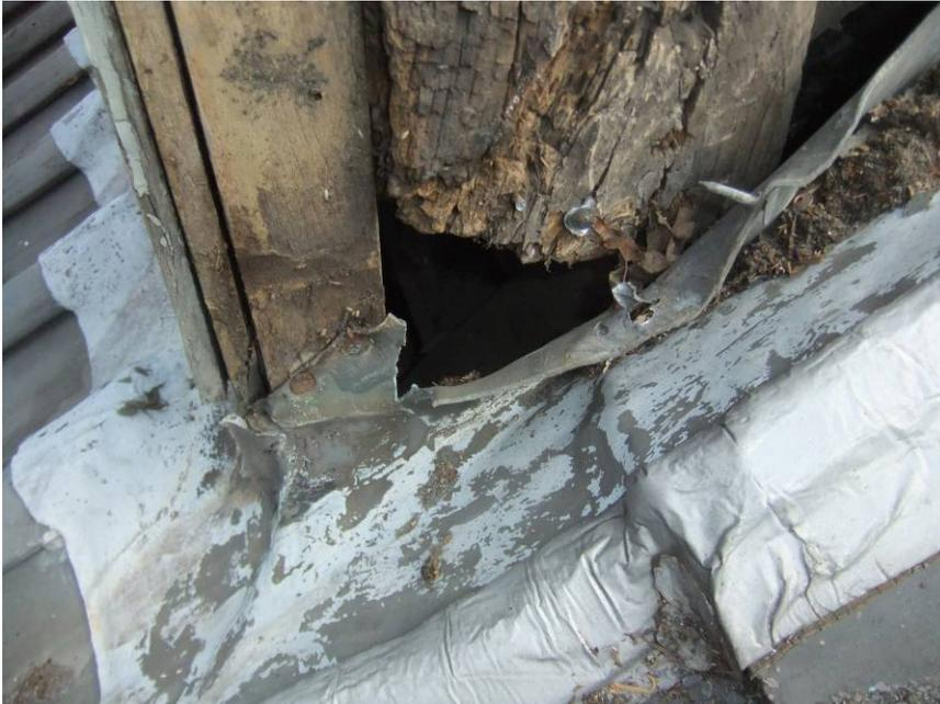
Detailaufnahme einer Gaube: Der Stiel ist nicht mehr mit dem Riegel verbunden, hängt in der Luft und wird quasi vom Fenster gehalten.
